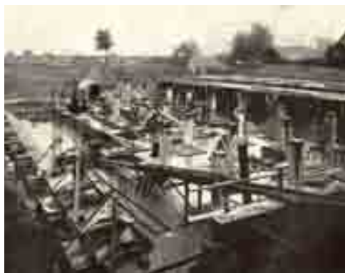
Die Bauarbeiten 1916: Die ersten Säulen sind bereits fertig gegossen.
