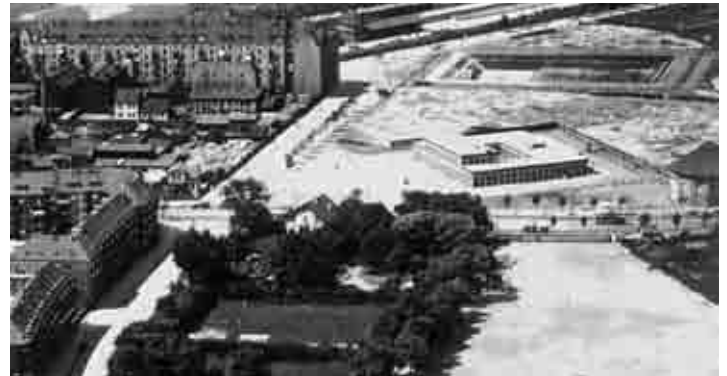
Luftbild von 1927: Unter der Rasenfläche re. im Vordergrund verbirgt sich das Rückhaltebecken. Dahinter das neue Arbeitsamt.
